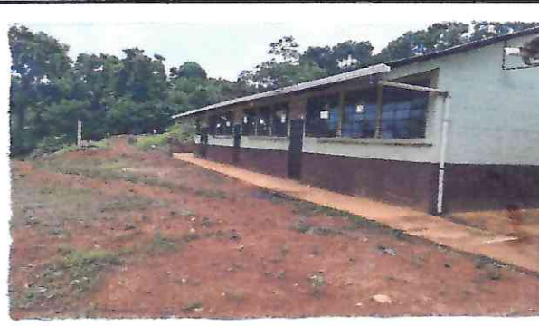
Foto 2: Reparación de Plancha de concreto de Patio
