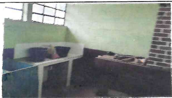
Foto 5: Instalación de Adulejo en Estufa Rural
