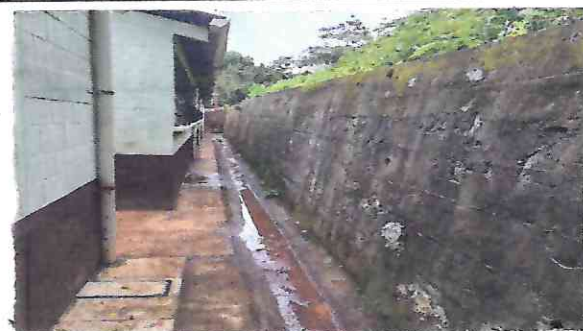
Foto 4: Pintura en Muros Exteriores e Interiores
