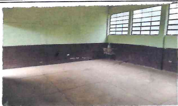
Foto 1: Sustitución de Piso Cerámico
